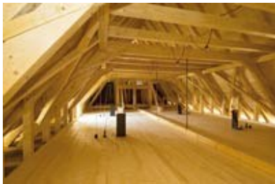
Dachstuhl der Bergkirche Rheinau
